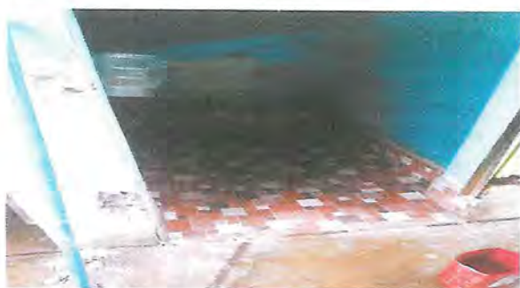
Foto 1: inicio de trabajos en colocacion del piso ceramico para los baños.
