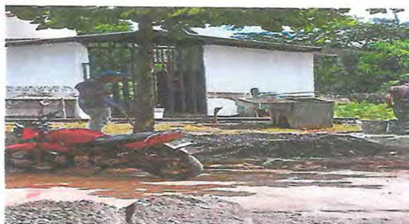
Foto 2: inicio de trabajos en base de cemento para la instalacion de la pila
